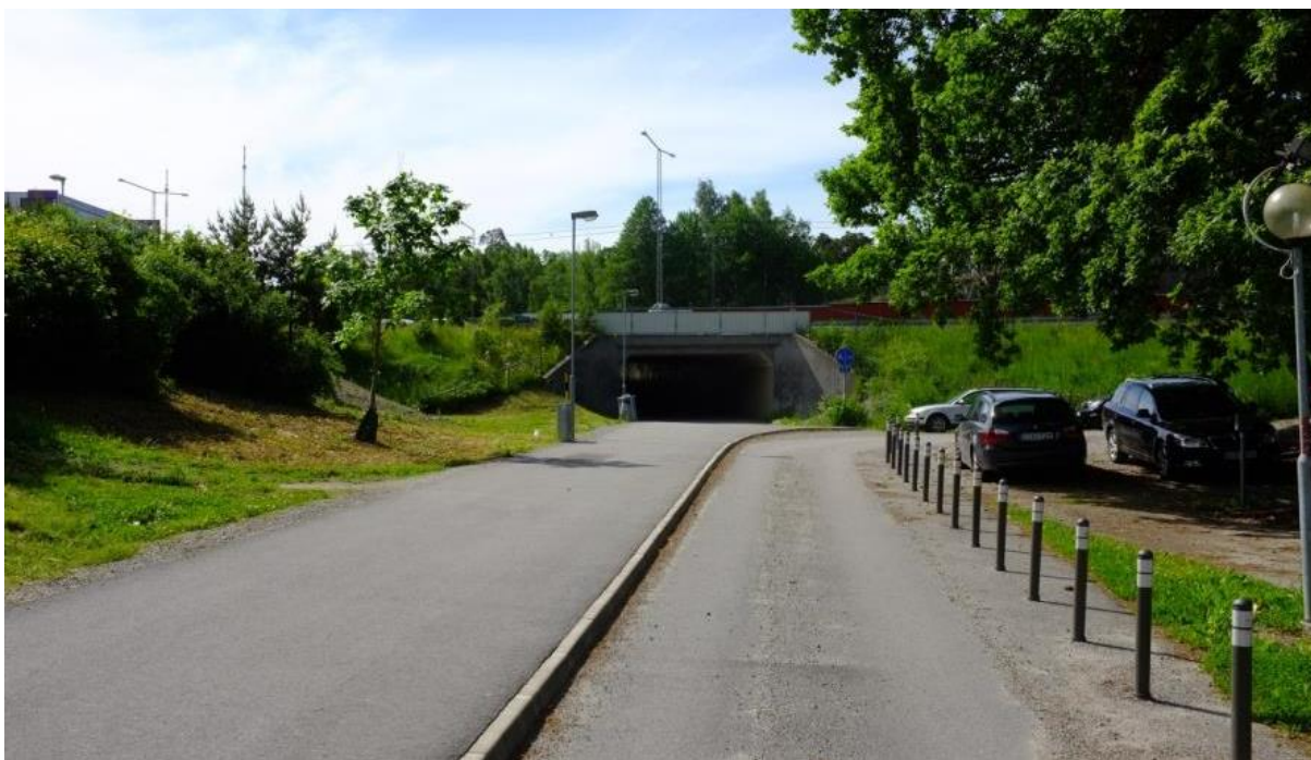
Figur 40 Exempel på gångstråk under Värmdöleden
