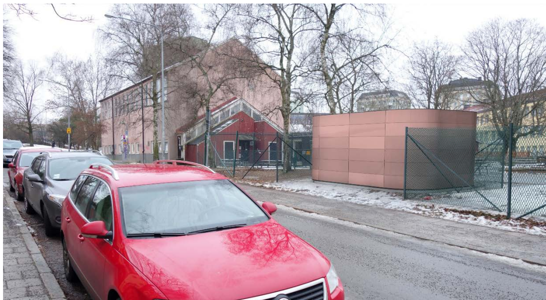
Figur 46. Brandgasschakt vid Klövervägen.
