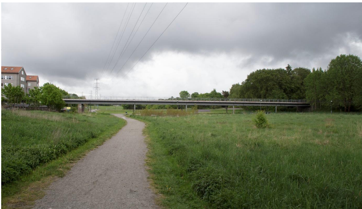
Figur 16. Vy tagen riktning österut med dagens spårbro över Gubbängsfältet.
