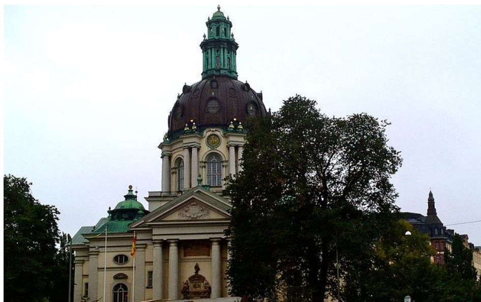
Fig. 21. Gustav Vasa kyrka september 2012. Foto Ebbis. Arkitekturens monumentalitet med referenser till romersk/katolskt stadsbyggande och barockarkitektur skymts eftersom träden vuxit sig stora.
