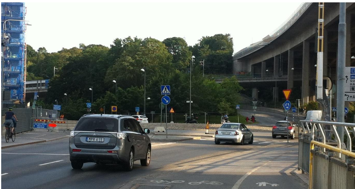
Figur 45 Vy mot söder från Skansbrogatan mot kvarvarande del av Stockholmsåsen och dess skogklädda sluttningar. Till höger i bild syns Skanstullsbron. Under den bron korsar bron för snabbspårvägen mellan Gullmarsplan och Hammarby sjöstad. Foto: Sweco
