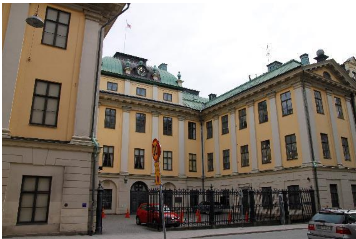
Figur 63 Bååtska palatset invid Blasieholmstorg uppfördes under 1660-talet efter ritningar av arkitekt Nicodemus Tessin d.ä. för riksskattmästare Seved Bååth. Byggnaden bildar tillsammans med omgivande bebyggelse från stormaktstiden en i huvudsak bevarad stadsbild från 1600-talets planläggning. Foto: Sweco
