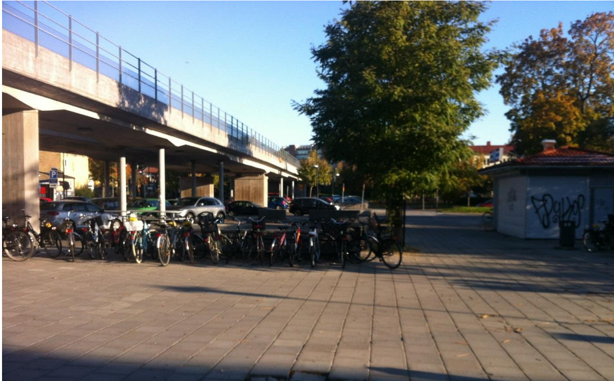
Figur 68 Den långa tunnelbanebron över dalstråket vid Sockenplan. Foto: Sweco
