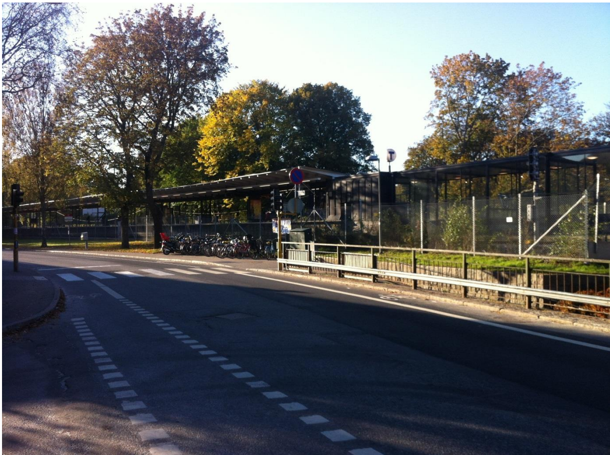
Figur 58 Enskede Gårds tunnelbanestation, sedd från Palmfeltsvägen. Foto: Sweco
