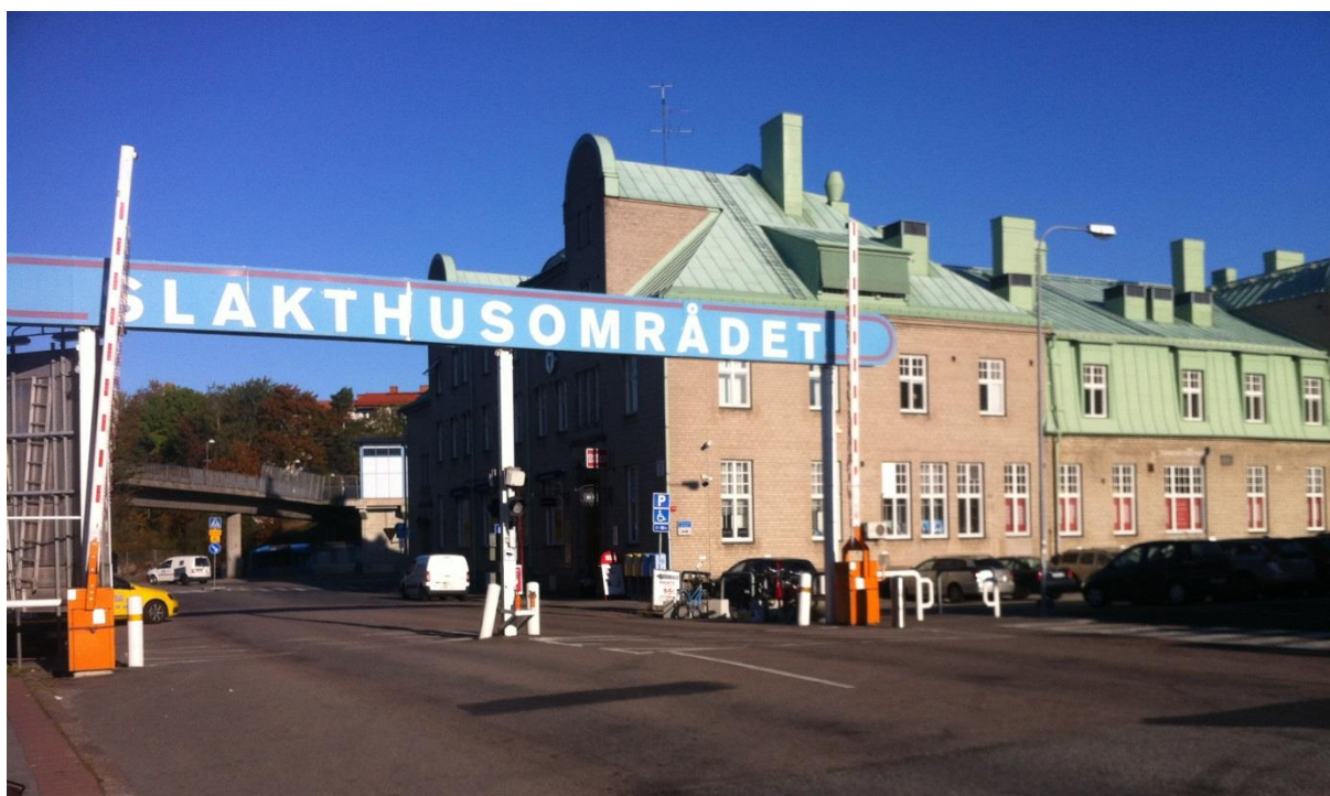
Figur 55 Slakthusområdets entré i norr. Foto: Sweco
