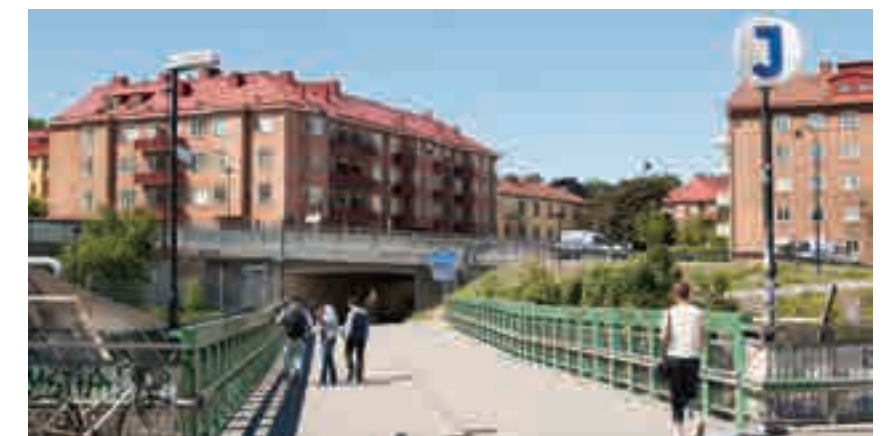
Vy från Solna Station mot framtida tunnelbane uppgång
