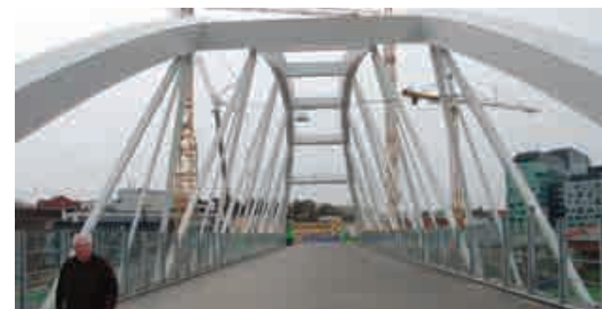
Ny uppgång planeras med anslutning till målbron
