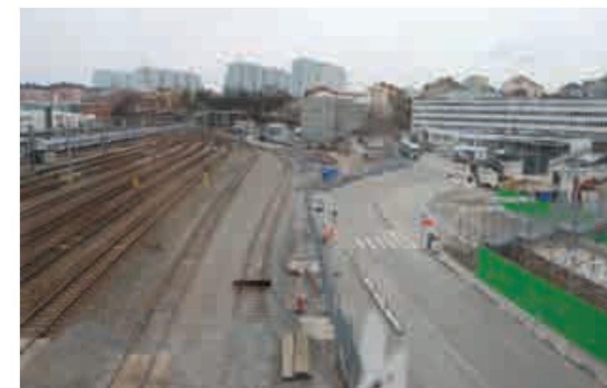
Norra biljetthallen anläggs under Råsta strandväg
