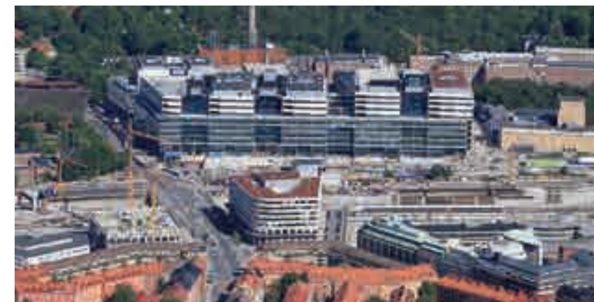
Vy över Hagastaden där fyra nya tunnelbane uppgångar planeras; Torsplan, Karolinska Institutet, Hagaplan och Karolinska sjukhuset
