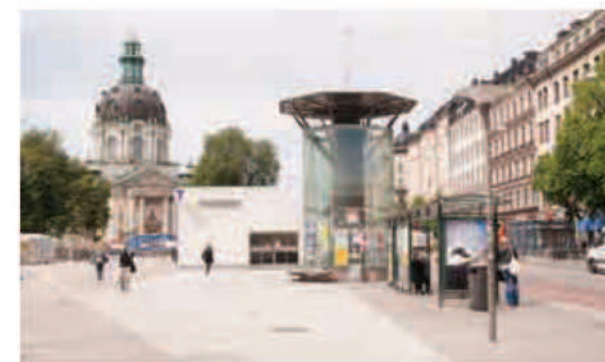
Befintlig utrymningsväg samt befintlig entrébyggnad
