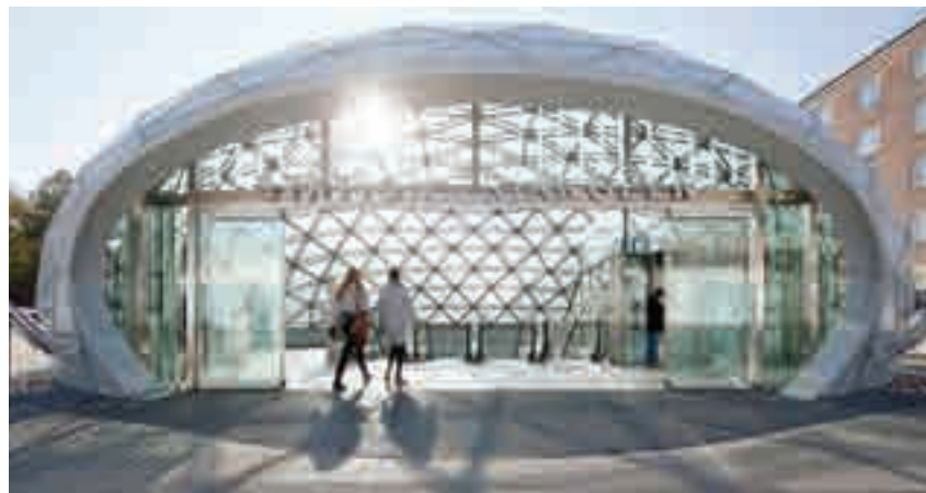
Exempel på fristående byggnad med tydlig identitet, Triangeln, Malmö
