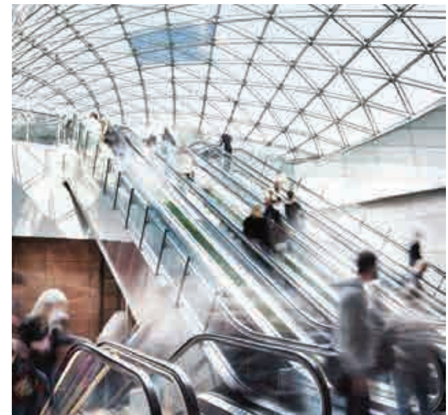
Friliggande entrébyggnad i glas med stort dagsljusintag Triangeln, Malmö
