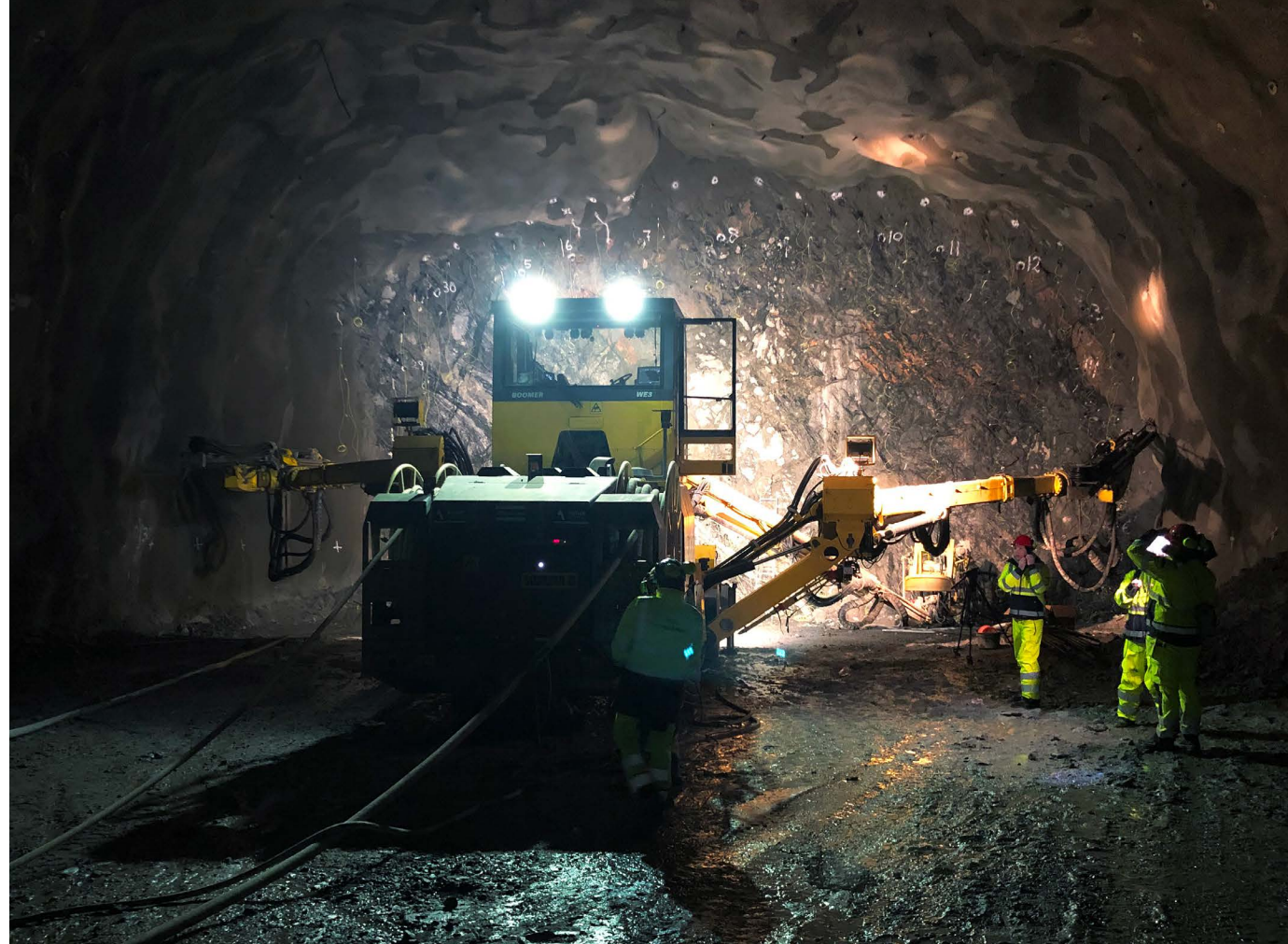
Arbetstunneln i Veddesta började byggas förra året. Nu fortsätter arbetet med spårtunnlar under 2020.
