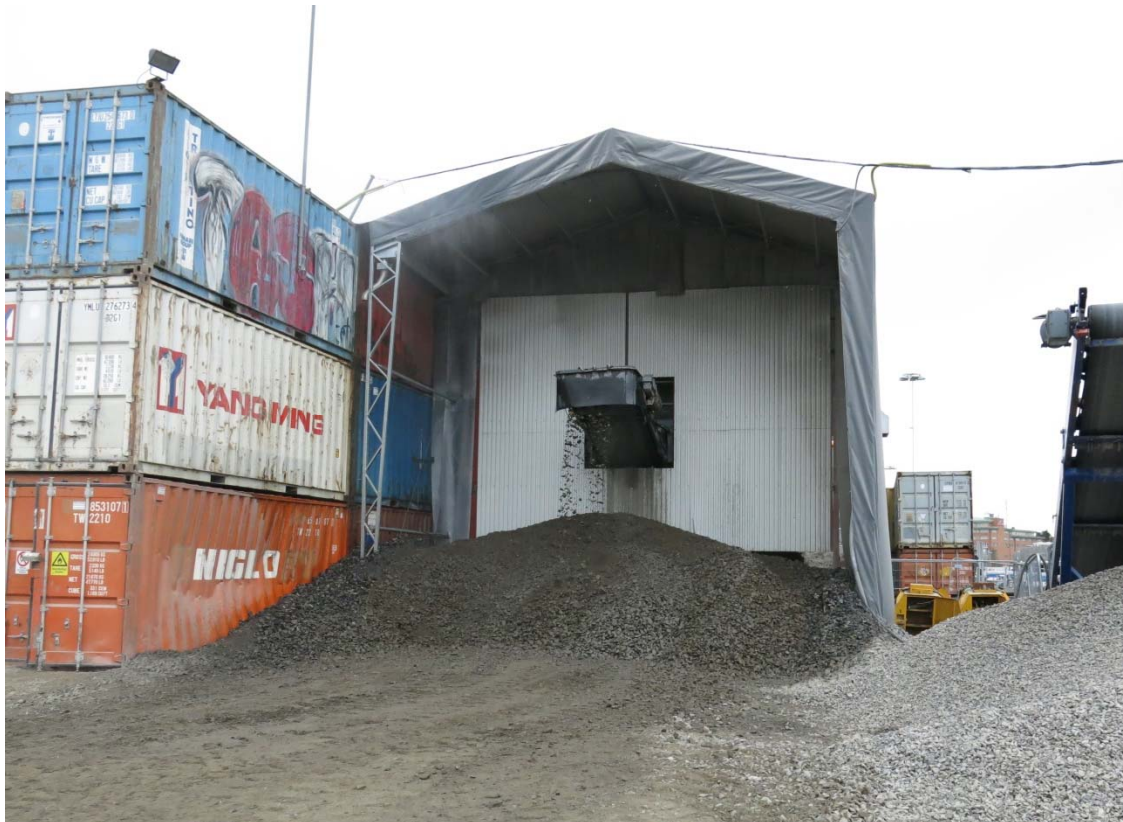
Figur 1 Exempel på en inklädd krossanläggning.
