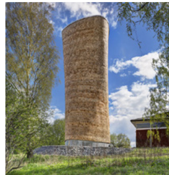
Figur 6.5. Exempel på ventilationstorn. (&Rundqvist arkitekter)
