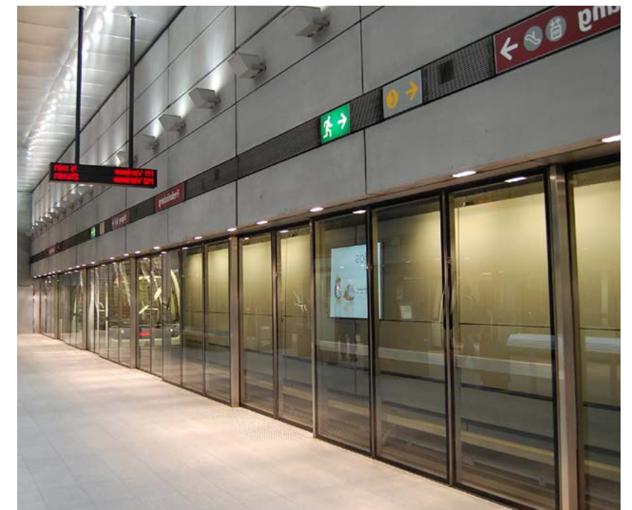
Belysning i spårtunnel, Köpenhamn
