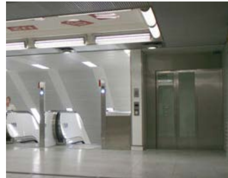
Snedhiss som har en kontinuerlig visuell förbindelse med rulltrapporna. Ref Hamburg
