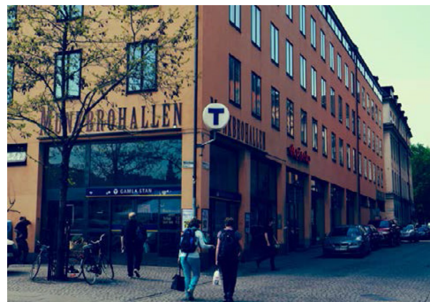
Entré över hörn i existerande byggnad. Gamla stan, Stockholm
