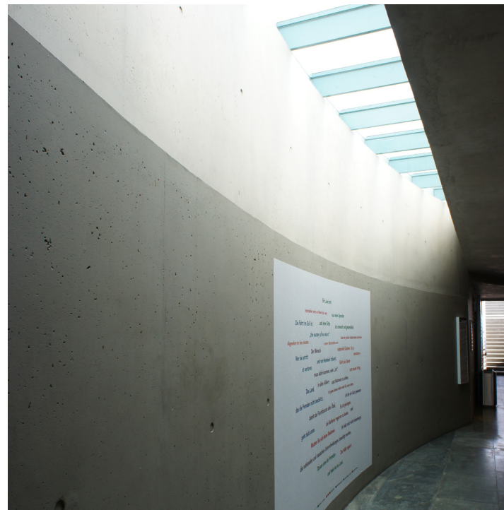
Dagsljusinsläpp i stationsuppgång. Dagsljuset skapar en känsla av kontakt med miljön utanför och hjälper till att vägleda resenären mot utgången. Station Bundestag Berlin.
